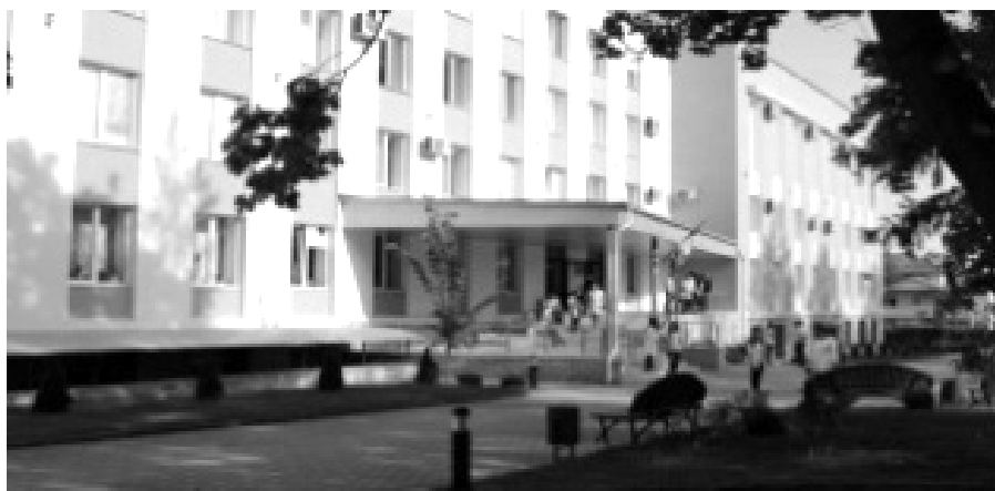
Blocul Facultății de Farmacie, renovat în anul 2014
