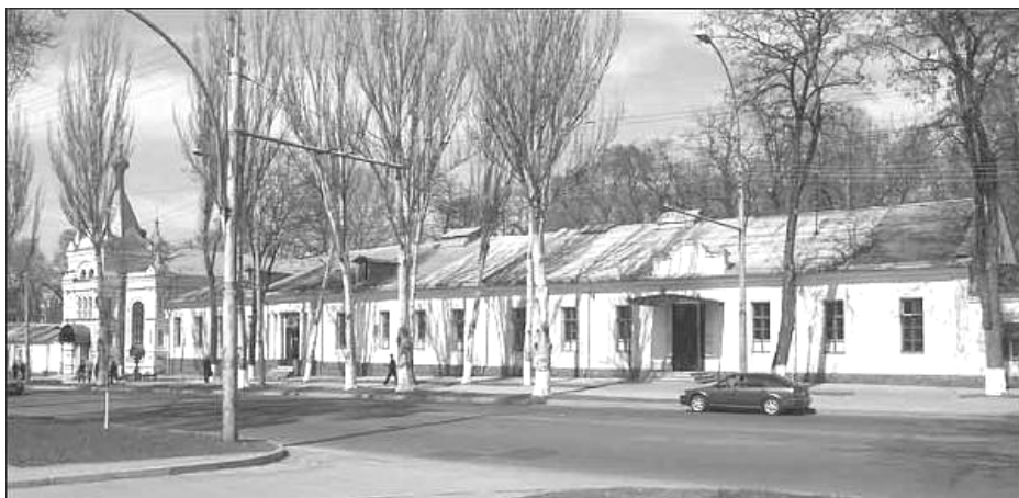
Aspectul Spitalului orașenesc din Chișinău (1817)
