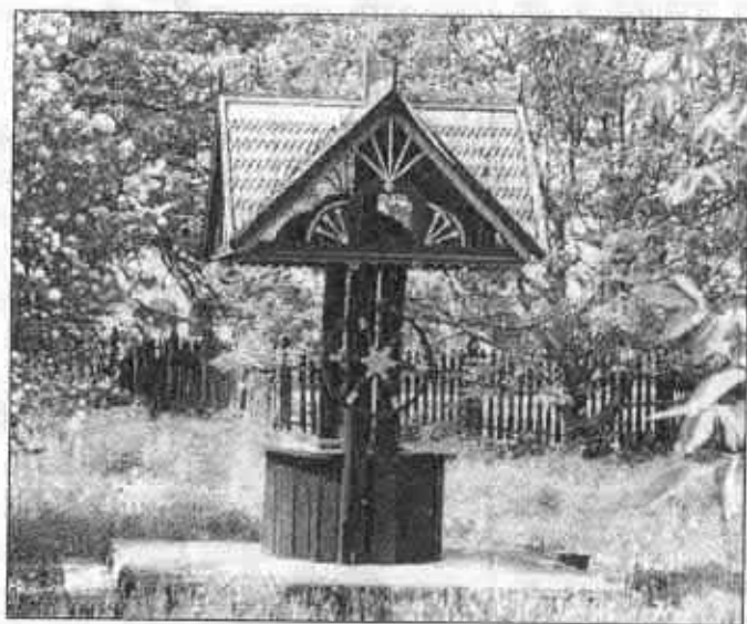
Fig. 11. Fântână săpată (cu acoperiș și capac) (după A. Overenco și coaut.).
