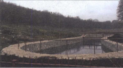
Rezervuare de apă/Water reservoirs
